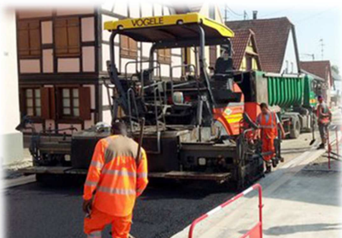
14 Août : Les goudronneuses rentrent en action. Le chantier sera terminé à temps.
